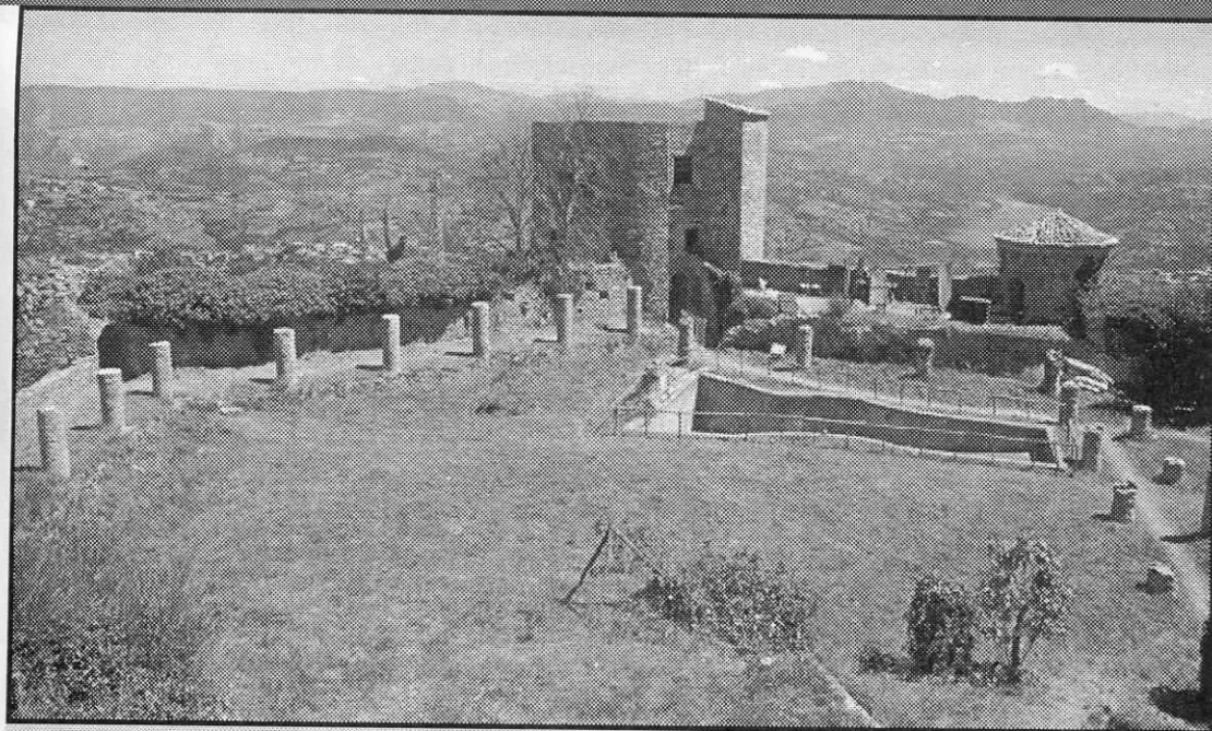
Piazzale interno; sulla sinistra la piscina di recente costruzione
