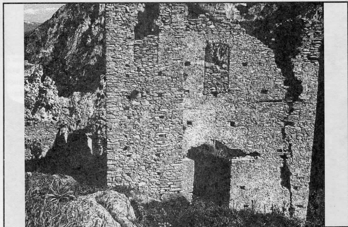
Fig. 4 - Chiesa di Santa Maria degli Angeli, la facciata prima dei restauri della Soprintendenza che ha effettuato un intervento conservativo delle murature proteggendo i colli delle murature operando con interventi di sarcitura e integrazione sulle numerose lesioni presenti.
