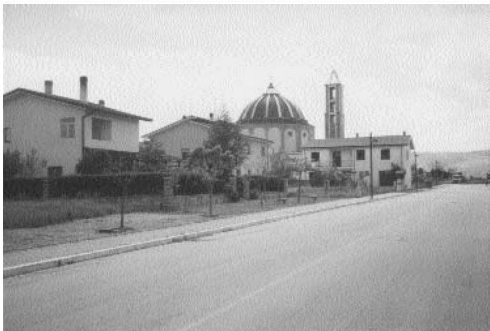
Fig. 13. Nuova Conza della Campania particolare della cupola e del campanile della chiesa Nuova.
