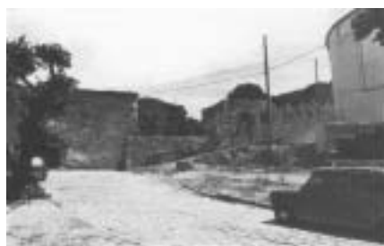
Fig. 2. Prospetto principale dell'Episcopio prima del sisma del 1980.
